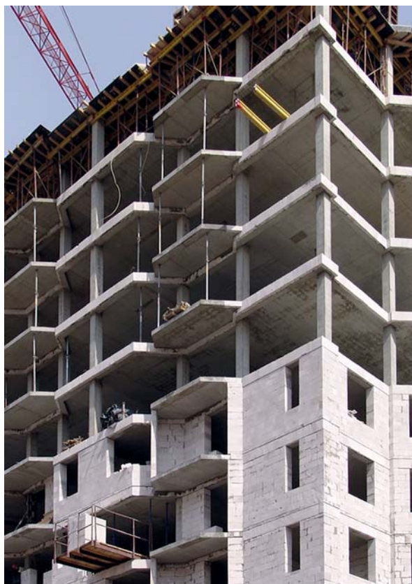
Рис. 3. Строительство монолитно-каркасных зданий с применением мелких ячеистобетонных блоков
