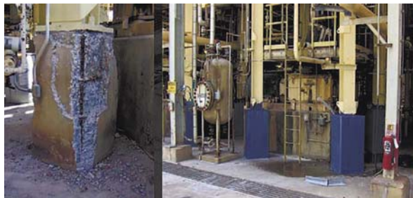
Рис. 6. Опоры реактора: а – до ремонта; б – после ремонта
