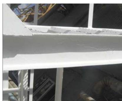
Рис. 4. Восстановленная поверхность
