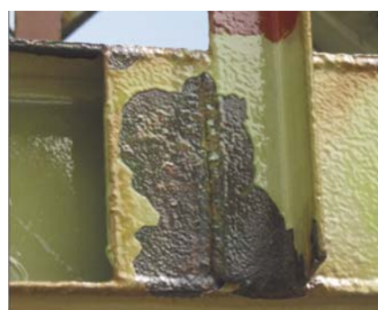
Рис. 3. Поверхность, обработанная герметиком Rustbond Penetrating Sealer
