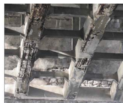
Рис. 5. Поврежденный бетон
