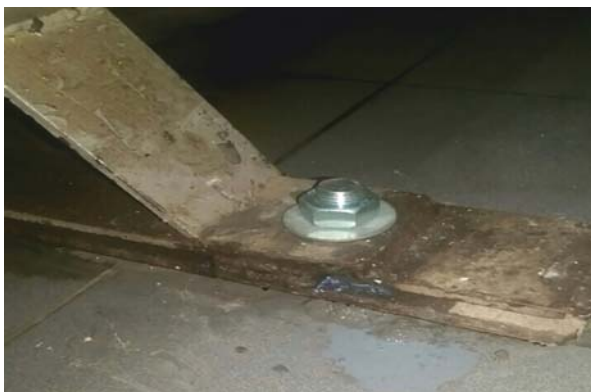
Рис. 6. Установка анкерного болта в скважину, заполненную акриловой композицией
