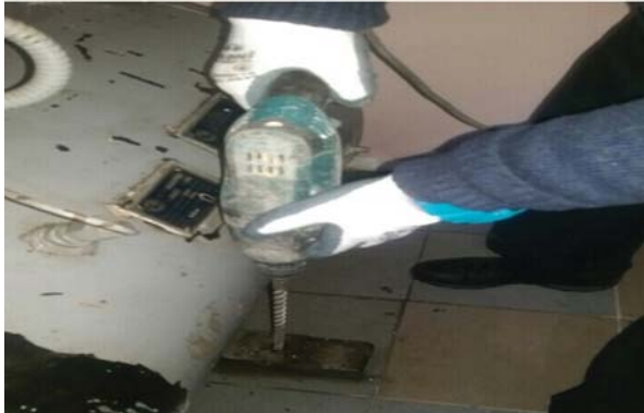
Рис. 4. Бурение скважины через станину оборудования
