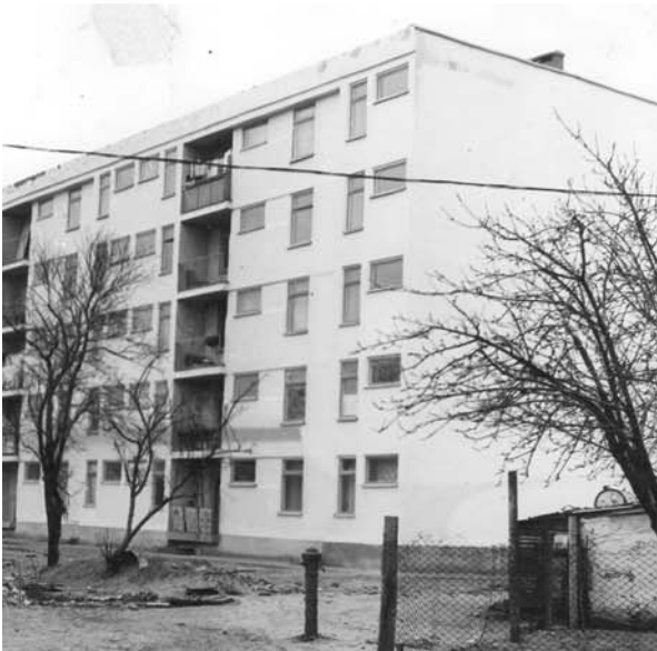
Рис. 2. Пятиэтажные дома массовой серии из крупных ячеистобетонных блоков
