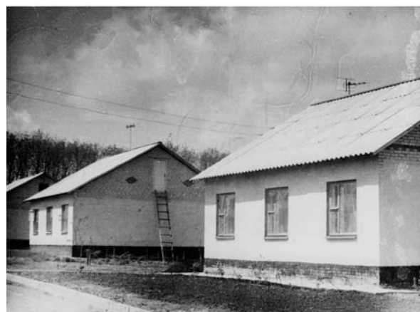
Рис. 1. Усадебные дома из крупных ячеистобетонных блоков
