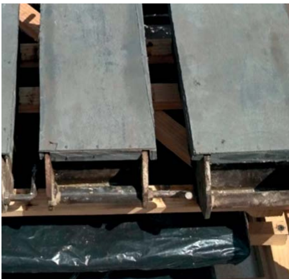
Рис. 2. Гідроізоляція плит і кубів
