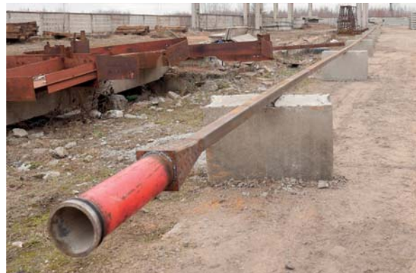
Рис. 4. Общий вид бетоновода
