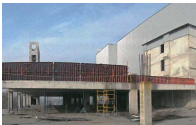
Рис. 6. Випробування фрагменту перекриття другого поверху. Навантаження прикладається шляхом наповнення ємкостей водою. Вигляд збоку
