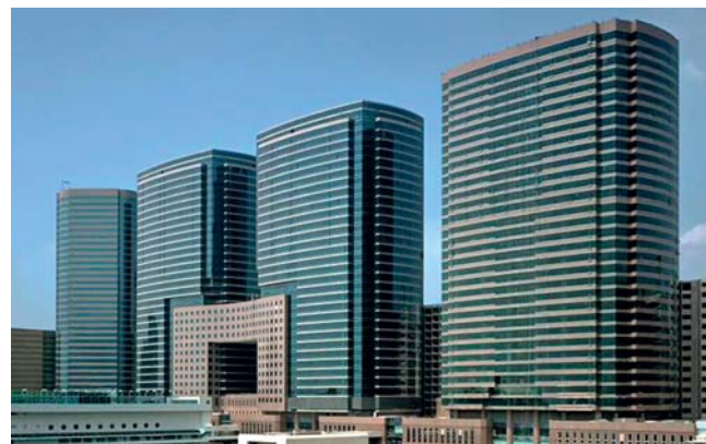
Рис. 1. Застосування постнапруження за технологією фірми VSL. Гонконг, Китай
