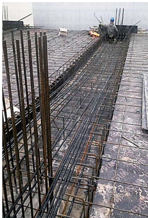
Рис. 3. Встановлення канатів для постнапруження балки монолітного переkritтя
