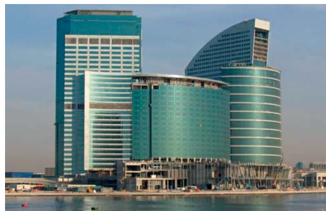
Рис. 2. Застосування постнапруження за технологією фірми VSL. Дубай, ОАЕ (фестивальне містечко). Загальна площа постнапруження 250 тис.м 2 . Гонконг, Китай
