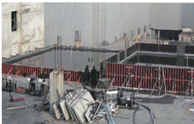
Рис. 5. Випробування фрагменту перекриття другого поверху. Навантаження прикладається шляхом наповнення ємкостей водою. Вигляд зверху
