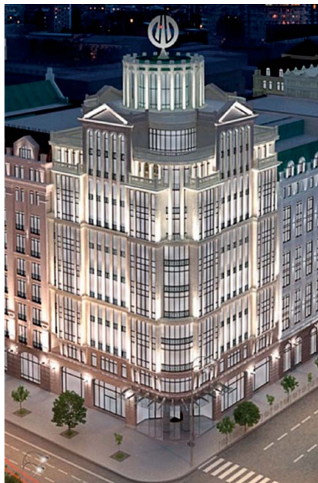
БЦ ASTARTA у Києві на перетині вулиць Нижній Вал і Набережно-Хрещатицька (Поділ) є першим в Україні об'єктом, який отримав у 2016 році сертифікат на відповідність міжнародному стандарту BREEAM Interim 2013
