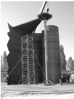
Фото 5. Выполнение сварочных работ с инвентарных передвижных подмостей
