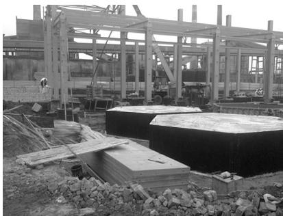
Фото 3. Возведение вертикальных стальных резервуаров в стесненных условиях
