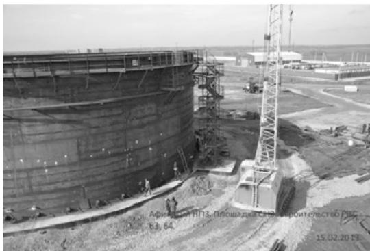
Фото 1. Строительная площадка при возведении стального цилиндрического резервуара
