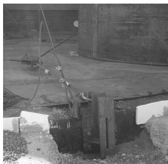
Фото 4. Разворачивание рулона с использованием однорольного блока и монтажной скобы
