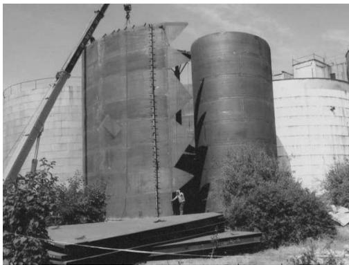
Фото 2. Возведение резервуара методом рулонирования
