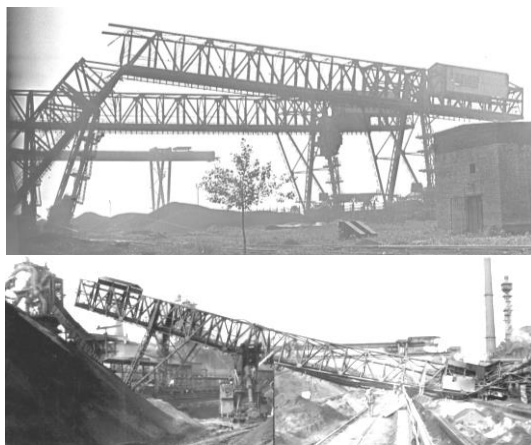
Рис. 2. Обрушение моста перегружателя решетчатого типа
