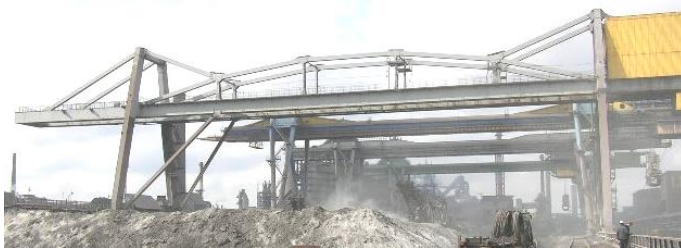
Рис. 1. Общий вид мостовых кранов-перегружателей на рудном дворе металлургического комбината
