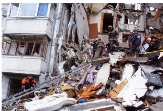
Рис. 2. Визначення характеру руйнувань візуальним оглядом завалу (м. Дніпропетровськ, 2007 р.)
