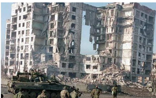
Рис. 1. Зруйнована будівля у Луганську
