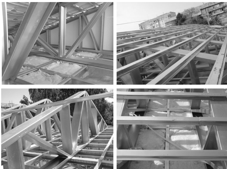
Рис. 1. Примеры конструкций на основе ЛСТК
