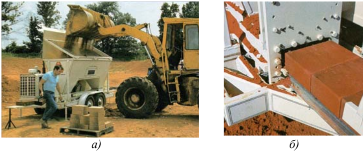
Рис. 2. Виготовлення ґрунтоблоків по технології «Терраблок»: а - дуплексна машина «Хандра-статик II»; б – готові ґрунтоблоки
