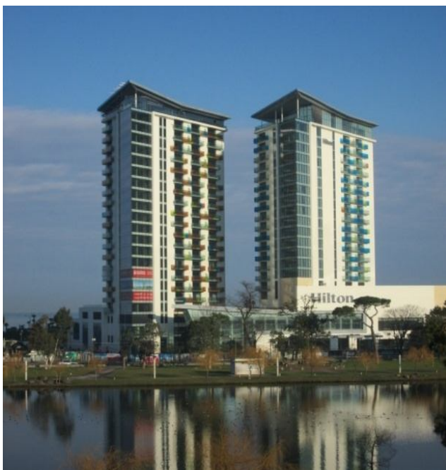
Рис. 8. Вид строящегося гостиничного комплекса «HILTON» в г.Батуми со стороны озера на период начала февраля 2015г. / View of the under construction hotel complex «HILTON» in Batumi from the lake for the period of February beginning 2015.
