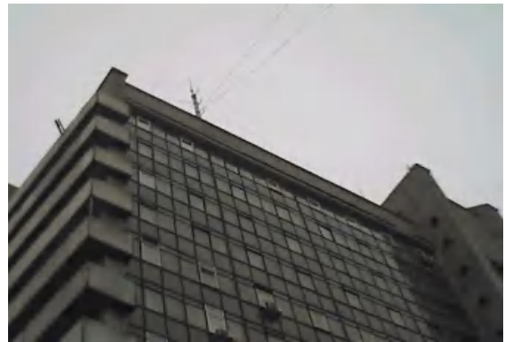
Рис. 4. Фотографія частини зовнішньої стіни будівлі ДВНЗ ПДАБА / Fig. 4. The photo of the outer wall of the building SHEE PSABEA
