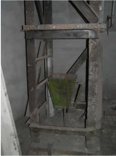
Рис 5. Элемент решетки сквозной опоры вырезан /The element of the lattice cut-through support
