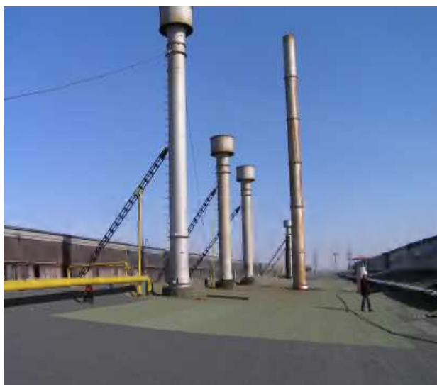
Рис 1. Общий вид металлических дымовых труб секционных печей трубопрокатного цеха № 1/
