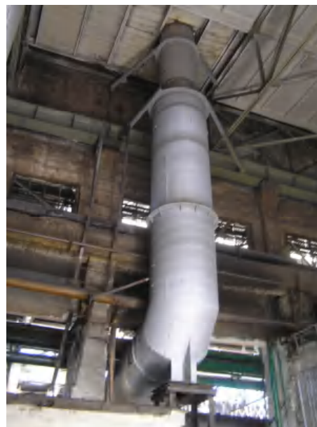
Рис 2. Общий вид металлической дымовой трубы внутри цеха/General view of the metal chimney inside the shop.
