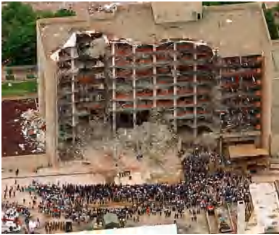
Рис. 2. Будівля «Alfred P. Murrah Federal Building» після теракту 19 квітня 1995р.
