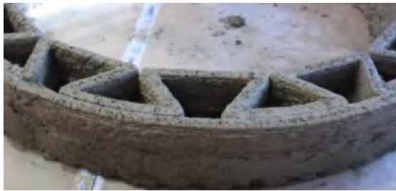
Рис. 5. Строительные конструкции армированные: а – фиброволокном; б – перегородками /
