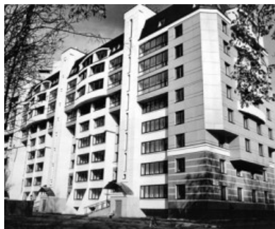
Фото 4. Здание после реконструкции
