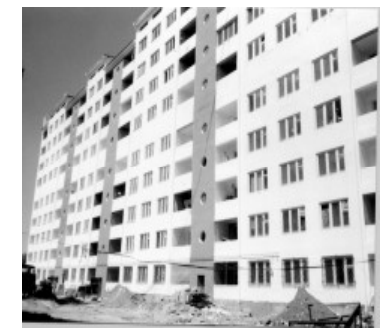
Фото 8. Здание после реконструкции
