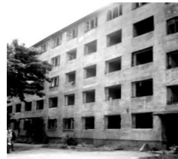
Фото 7. Здание до реконструкции
