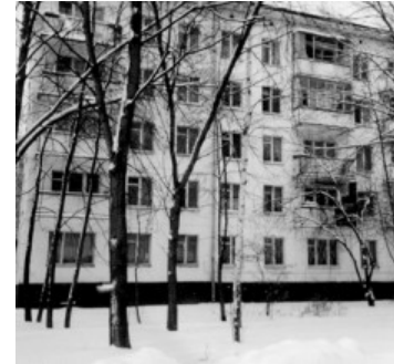
Фото 5. Крупнопанельная 5-ти этажка
