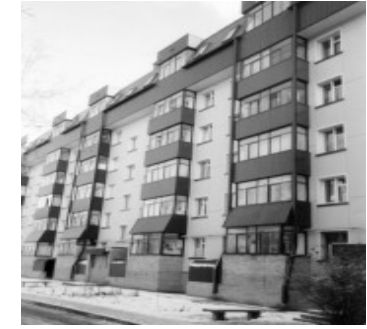
Фото 6. Здание после реконструкции
