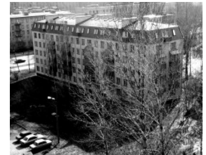
Фото 2. Здание после реконструкции
