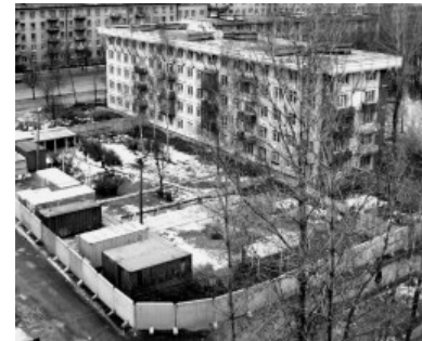
Фото 1. Здание до реконструкции
