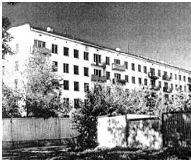
Фото 3. Здание до реконструкции
