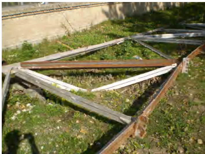
Рис. 4. Второстепенная ферма покрытия после демонтажа.
