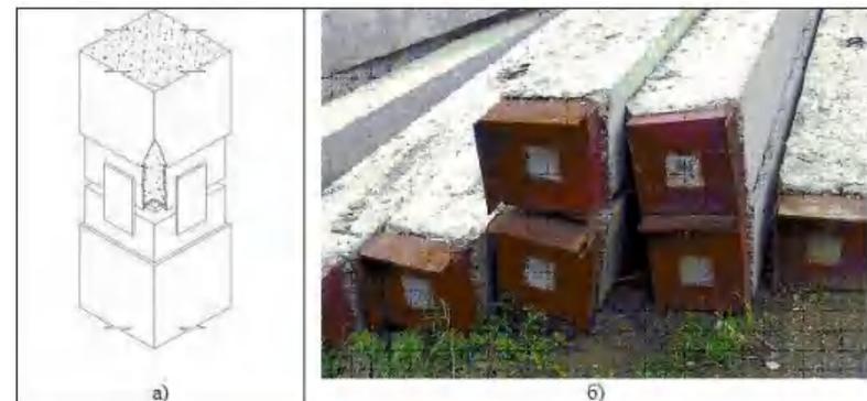
Рис. 2. Сварной стык составной сваи: а) - схема; б) - общий вид элементов
