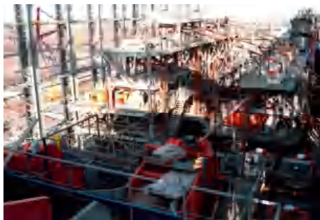
Рис. 3. Монтаж металлических конструкций та обладнання модуля 400 та 450
