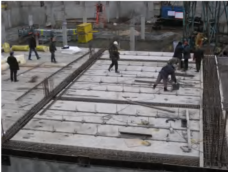
Рис. 2. Фрагмент перекрытия в процессе монтажа
