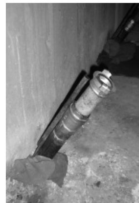
Рис. 3 Общий вид инъектора
