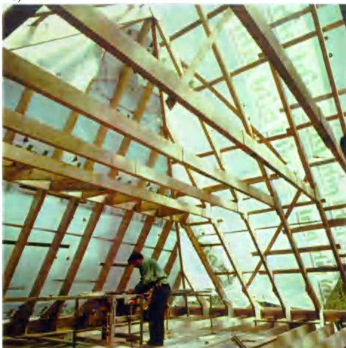
Рис. 1. Надбудова з використанням оцинкованих сталевих термопрофільей а) та дерев'яних конструкцій б)
