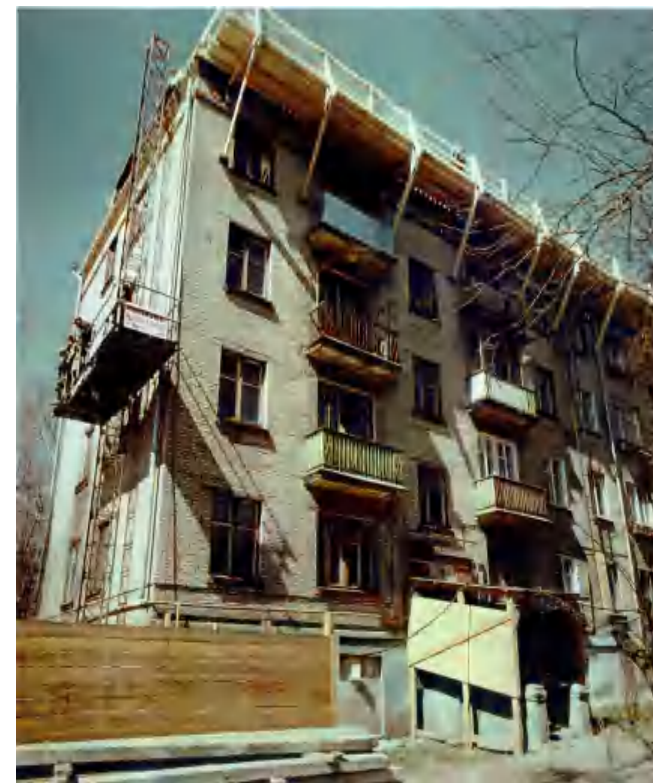
Рис. 2. Вигляд на будівлю, що реконструюється
