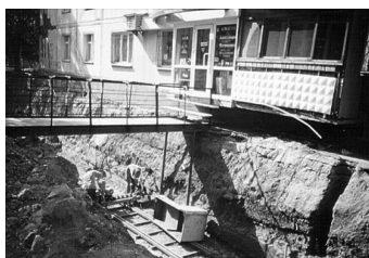
в) бурение скважин
