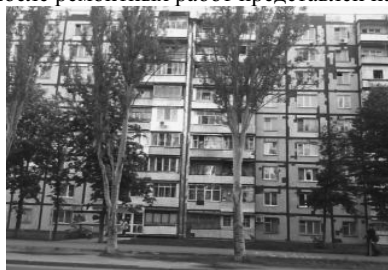
Рис. 13 Состояние здания после выравнивания крена.
