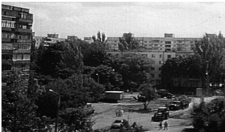
Рис. 2 Общий вид строительной площадки до начала ремонтно-восстановительных работ
