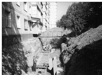
а) монтаж оборудования
