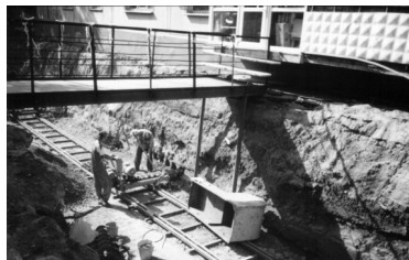
б) установка оборудования
