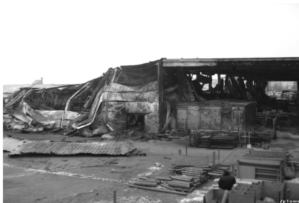
Рис.1. Магазин стройматериалов после пожара
