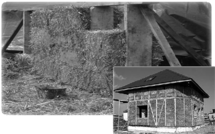
Рис. 2. Використання соломи при зведенні екологічних будинків
