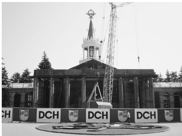
Рис. 2. Реконструкция здания VIP-терминала аэропорта в г.Харькове.
