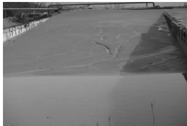
Рис. 1. Шламоотстойник Шархинского карьера объемом 5 тыс. м 3
