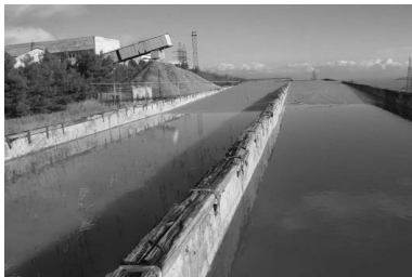
Рис. 1. Шламоотстойник Шархинского карьера объемом 5 тыс. м 3
