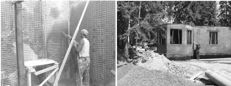
*Рис. 7. Обетонирование поверхностей панелей*
