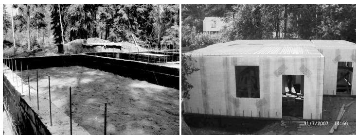
Рис. 6. Монтаж стен и перекрытия
