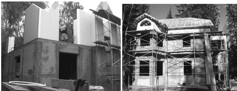
*Рис. 8. Монтаж стен и перекрытия второго этажа*
