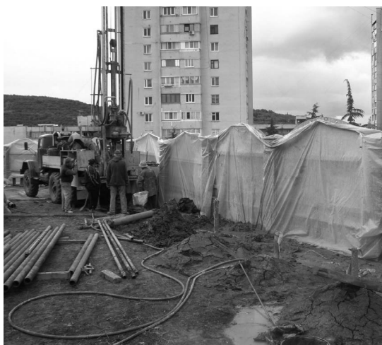
Рис. 6. Сооружение свай второго этапа защиты
