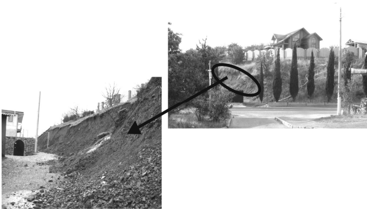
Рис. 2. Подрезка склона строящегося здания в. г. Алушта
