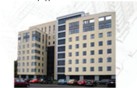
Здание каркасного типа. Основные несущие конструкции выполнены из монолитного железобетона. Колонны – монолитные железобетонные, размером 500x500 мм. Перекрытия и покрытие – монолитный железобетон.
