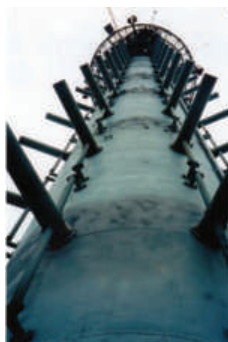
Рис. 8. Вид на антенный ствол от отм. + 385.0 м
