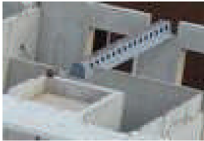
Рис. 1. Установка сталебетонной балки в крупнопанельном здании с последующим монтажом на балку пустотных плит [1].
