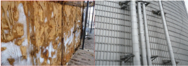
Рисунок 1. Фрагмент стены резервуара после 20 лет эксплуатации (ППТУ и FOAMGLAS®).
