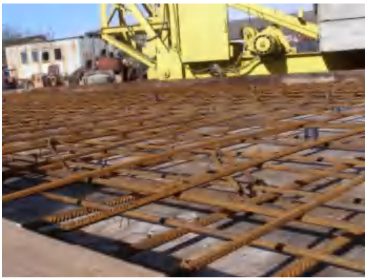
Рис.4. Анкерний пристрій та схема розміщення арматури
