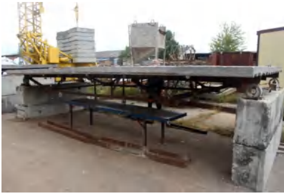
Рис.7. Загальний вигляд експериментальної натурної конструкції.
