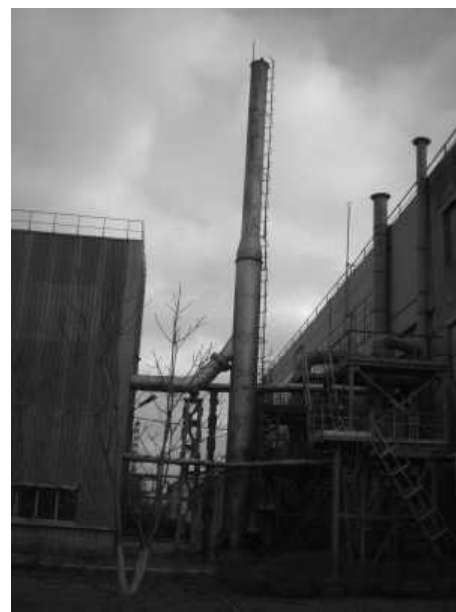
Рис 2. Общий вид металлической дымовой трубы высотой 24.00м газоочистки сушильного барабана /
