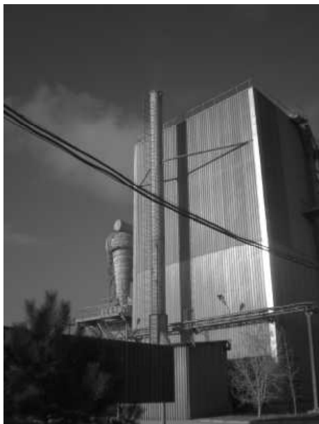
Рис 1. Общий вид металлической дымовой трубы высотой 25.00м газоочистки мартеновского цеха /
