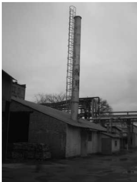
Рис 3. Общий вид дымовой трубы высотой 17.80м печи обжига огнеупоров /General view of the chimney height 17.80 m kiln refractories
