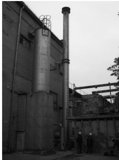
Рис 4. Общий вид металлической вентиляционной трубы высотой 19.9м энергетического цеха компрессора забора воздуха/ General view of metal vent pipe with a height of 19.9 m energy shop compressor air intake
