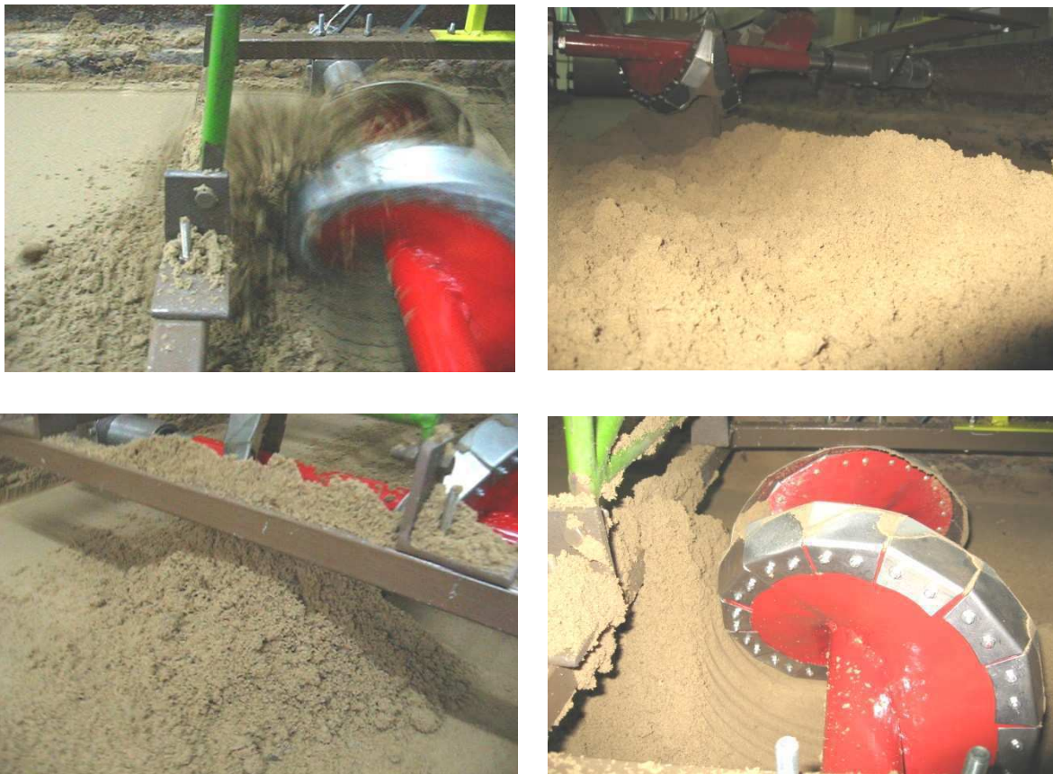
Рис. 2. Копання ґрунта без захисного кожуха.
