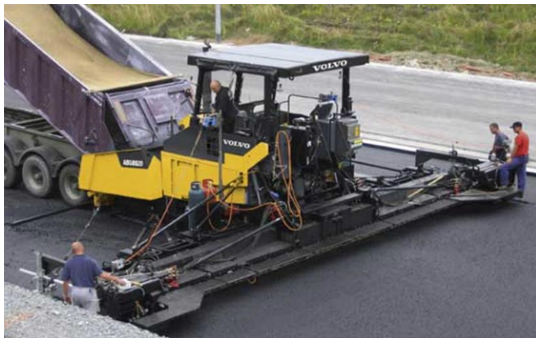
Рис. 2. Согласованность машин задействованных при строительстве дорожного полотна.
