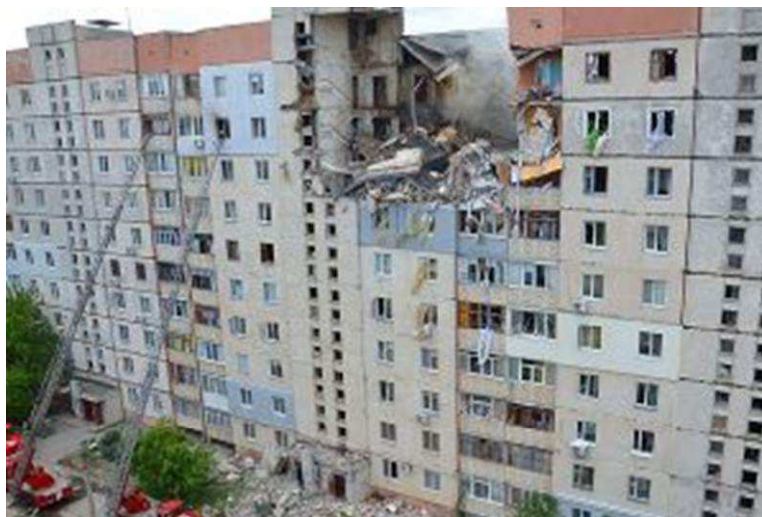
Рис. 1. Наслідки вибуху газу у будинку по вул. Лазурна, 40 у м. Миколаєві.
