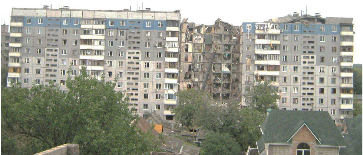
Рис. 3. Наслідки вибуху газу у будівлі серії І-464Д-83 по вул. Мандриківська, 127 у Дніпропетровську (2007 р.).
