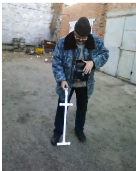
Рис. 6 Определение местоположения грунтопрокалывающей головки при проколе.
