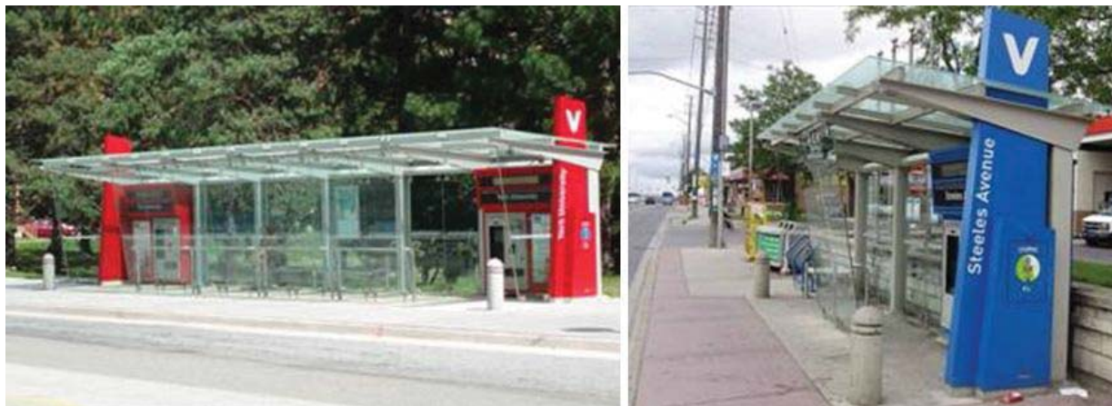
Рисунок 8 – Остановки, оборудуемые защитными армированными полуметровыми столбиками, увеличенной высотой тротуара и защитой от брызг из-под колёс проходящего мимо транспорта – оснащённый остановочный павильон с остеклёнными перегородками
