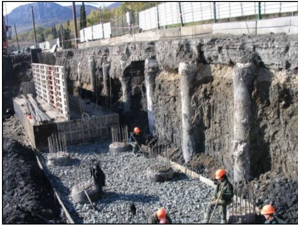
Рис. 5. Укріплення дорожнього полотна буронабивними пальями для стримування зсувних процесів Південного берега Криму
