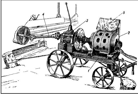
Рис. 19. Передвижной электродвигатель на тележке в работе по приводу круглопильного станка (1924 г.)
