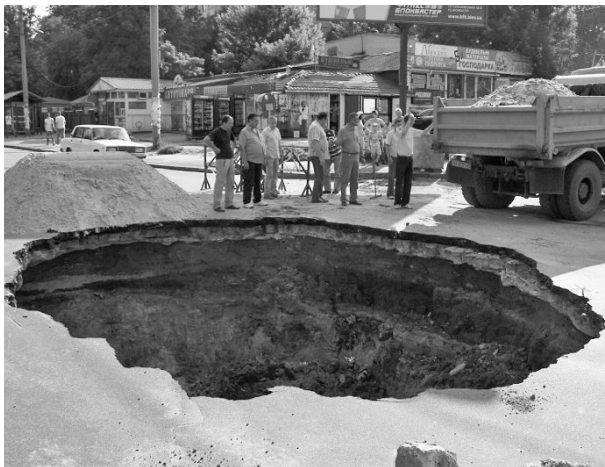
Рис. 1. Провал ґрунту на шляховому полотні у м. Києві по вул. О. Теліги
