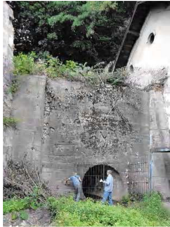
Рисунок 1. Загальний вигляд ПС ґрунтового схилу та вхід в ДГ.
