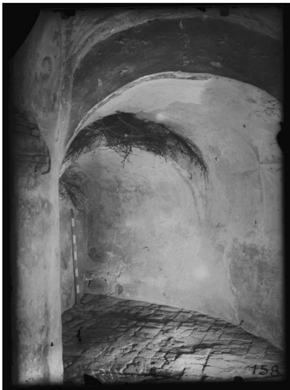
Мал. 2. Приміщення у нижній частині північної вежі. Стан до реставрації. 1935 р. Фото з наукового архіву НЗСК. КП – 212. Інв. № 4191.
