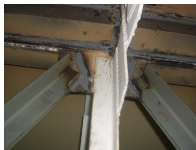
Рис. 8. Устройство подкосов шпренгелей
