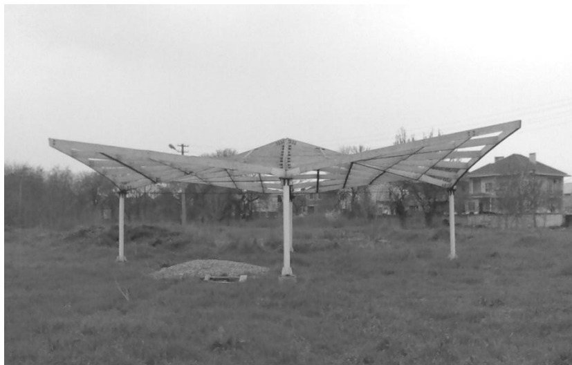
Рис.1 Четырехлепестковая сборная деревянная гиперболическая оболочка.(Одесса 2012)
